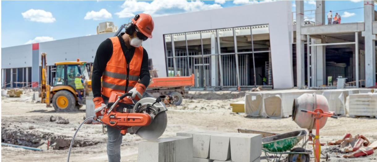
Metzingen, 24. Januar 2019 – Trennschneider sind auf vielen Großbaustellen und im Straßenbau unverzichtbar. Als Werkzeug zum Schneiden von harten und massiven Materialien wie Stein oder Beton und Stahl kommen Sie flexibel zum Einsatz. Auf dem Wagen für die Straßeninstandhaltung oder handgeführt beim Schneiden von Wänden oder dem Trennen von Armierungen. Schwere Arbeiten in rauer Umgebung. In der Anwendung sind Trennschleifer entsprechend laut, dreckig, unhandlich und wartungsintensiv.
